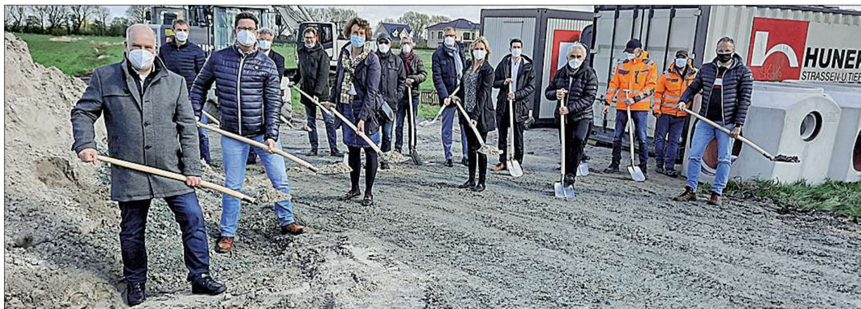
Symbolischer Start mit Schaufeln: Zum Beginn der Erschließungsarbeiten konnte Hans Thünemann von der EOC Immobilien GmbH aus Kluse (rechts) gestern Vormittag unter anderem Bürgermeisterin Beatrix Kuhl, Stadtwerke-Chef Claus-Peter Horst, Ortsvorsteher Sönke Eden, Tiefbau-Unternehmer Frank Huneke, Anwohner Arnold Kroon sowie Vertreter der Ratsfraktionen, der Stadtverwaltung und der Ostfriesischen Volksbank begrüßen.
