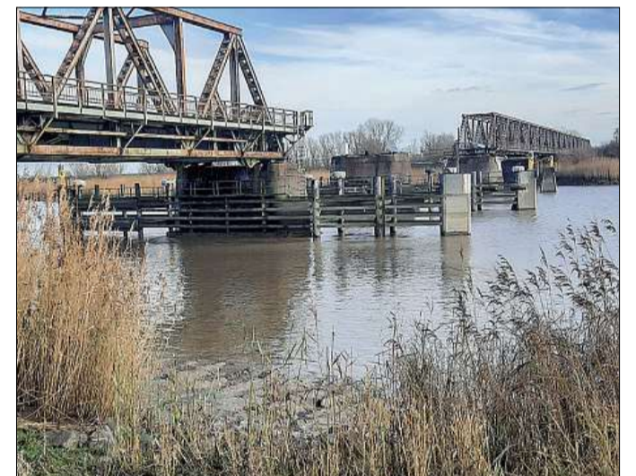
Die noch bestehenden Überbauten der Friesenbrücke in Weener sollen in fünf Teile zerlegt und dann einzeln mit einem Schiff in den Papenburger Hafen transportiert werden.
